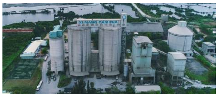
Nhà Máy Xi Măng Cẩm Phả
