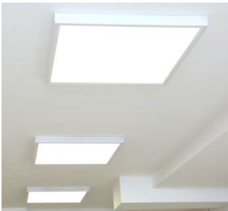
Lắp đặt ốp nổi
