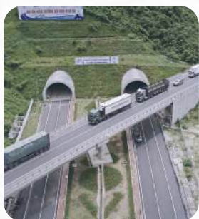
Dự án Hầm Đèo Cả
