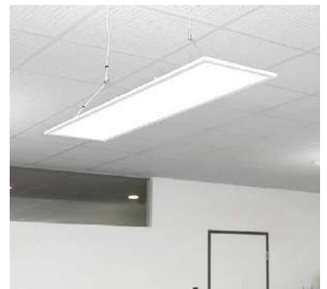
Lắp đặt thả trần
