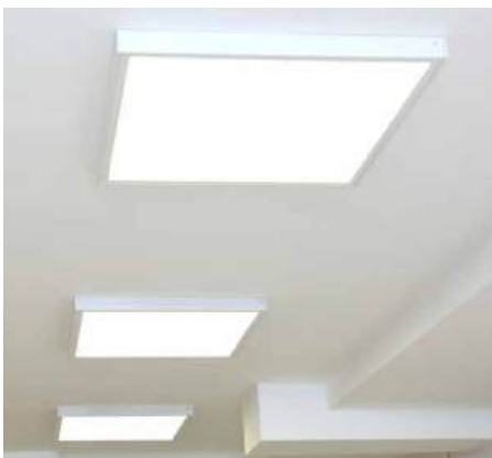
Lắp đặt ốp nổi
